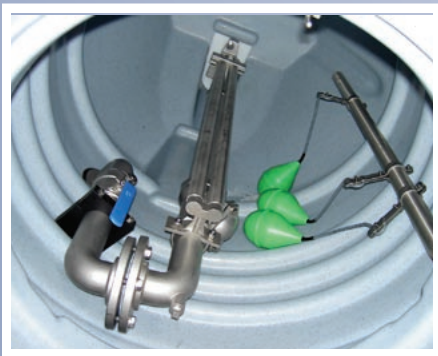
Трубопровод и элементы автоматической муфты изготовлены из нержавеющей стали AISI 316
